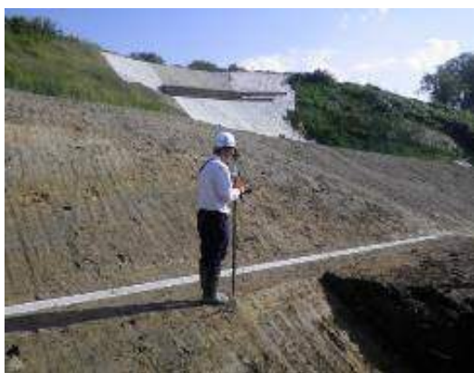
○ 出来形確認の状況
