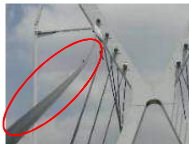
ケーブル損傷・緩み状況
