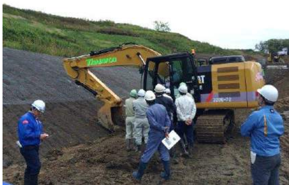
○ ICT技術活用工事現場研修
