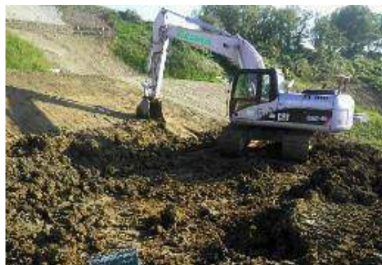
○ ICTバックホウによる法面整形
