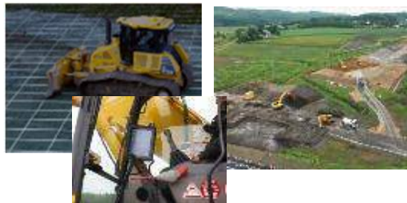
ICT建機での施工
