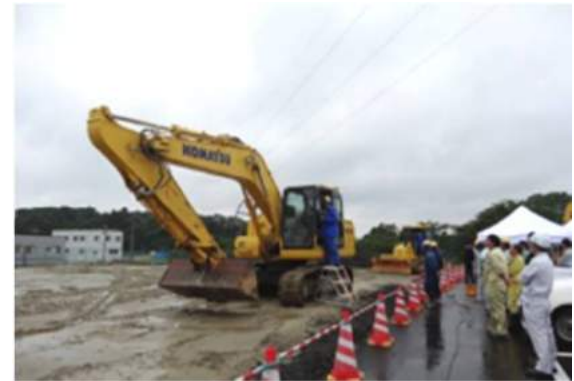
i-Construction「ICT見学会」(宮城県建設業協会)
