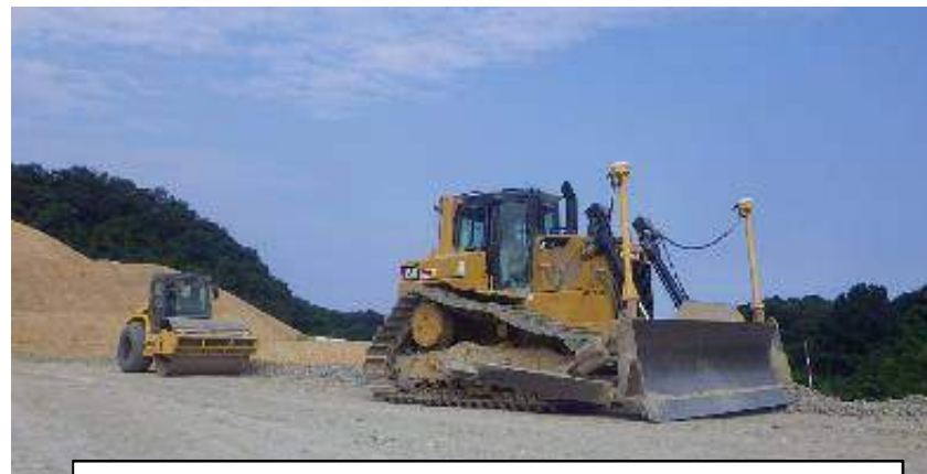
地場の測量機器メーカー等の連携により 後付け機器でICT施工を実施
