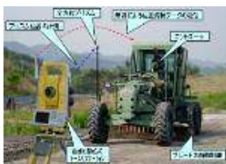
ICT舗装の導入
