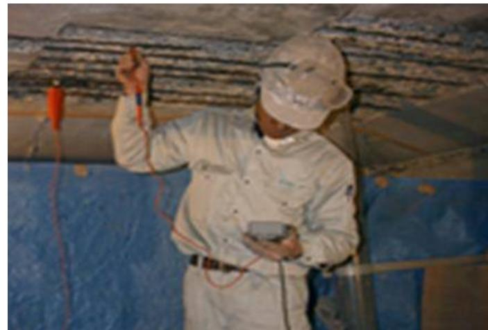
マルチメータを用いて排流線と鉄筋間の導通を確認し、
