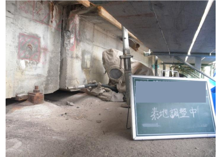
3. 素地調整(ブラスト処理)
