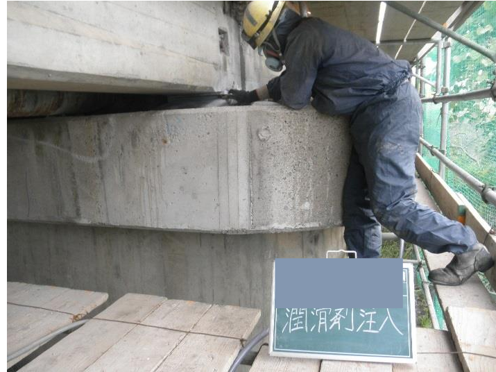
2. 潤滑性防錆剤の注入
