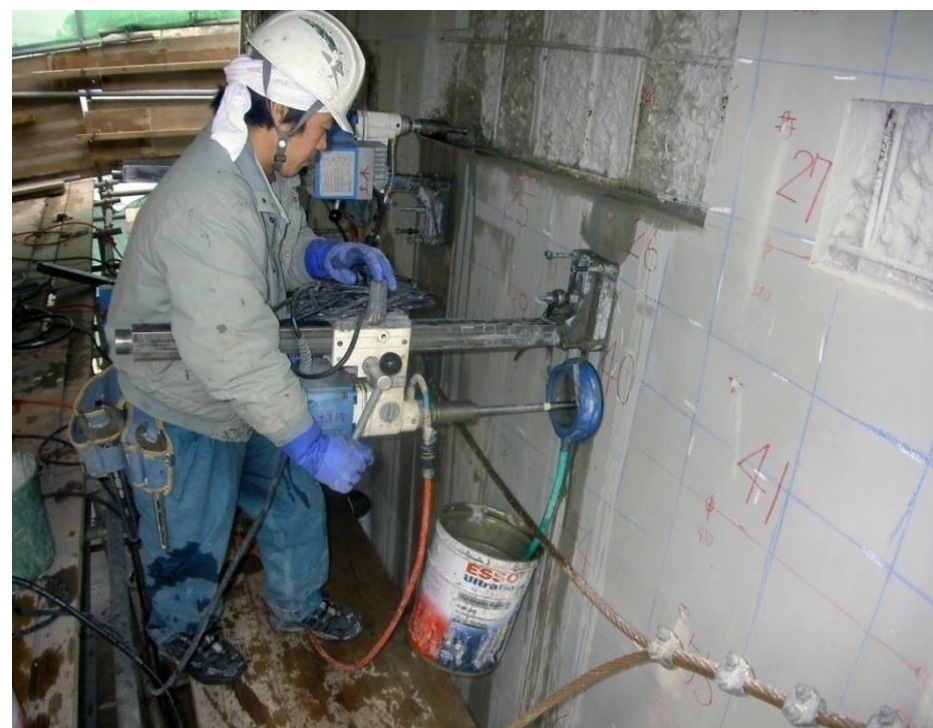
④圧入孔削孔
