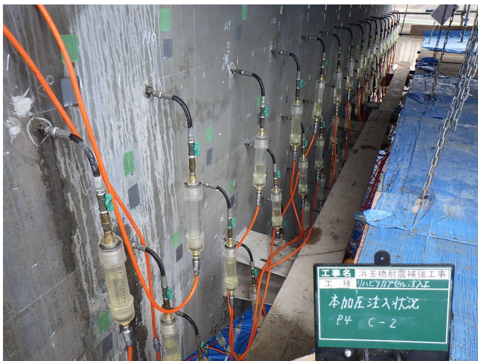
⑦本注入工
