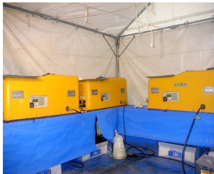
⑥圧入装置の設置
