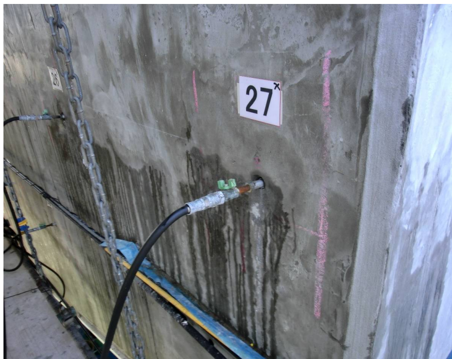
⑦試験加圧注入工
