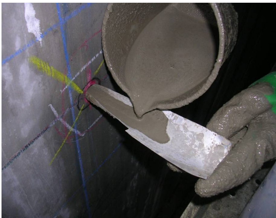
⑨圧入孔充填工
