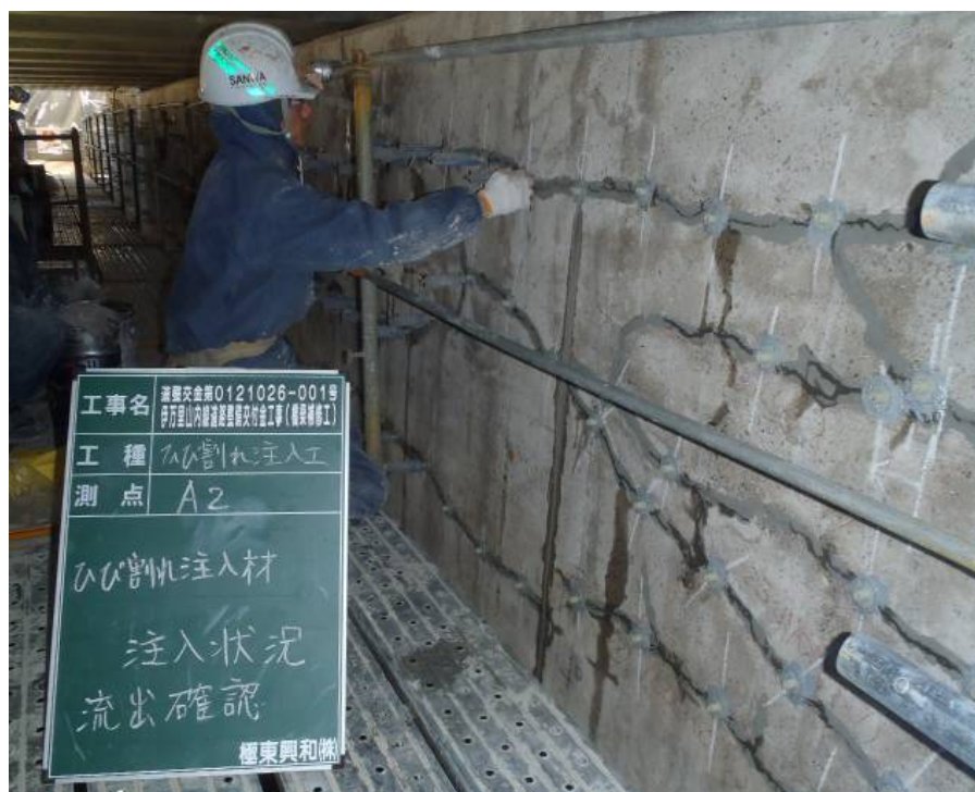
①表面漏出防止（ひび割れ注入）
