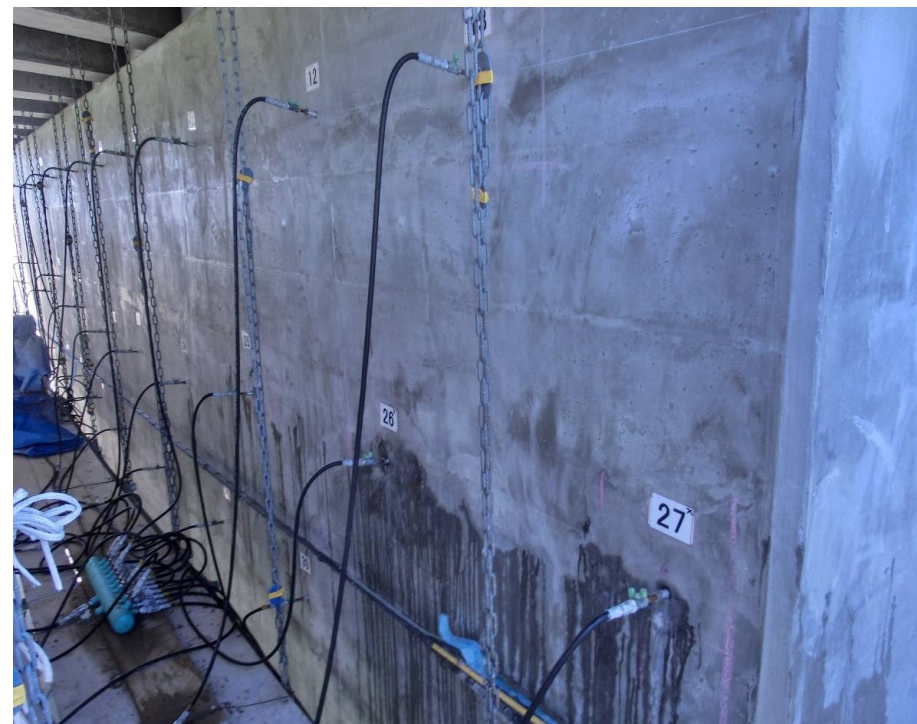
⑧本加圧注入工
