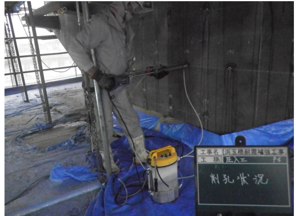
④圧入孔削孔
