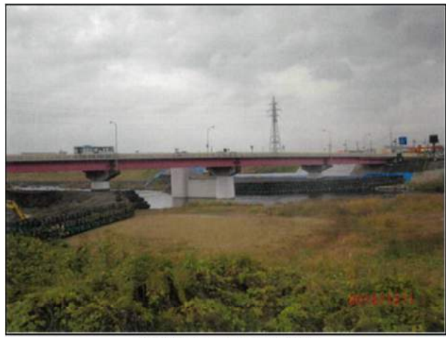
橋梁側面の状況
