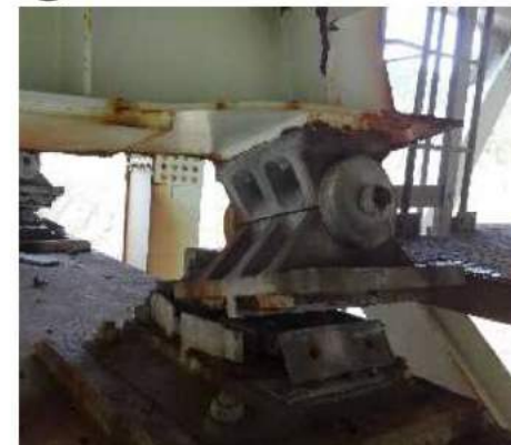
橋梁の支承・主桁の損傷 (大分自動車道・並柳橋)
