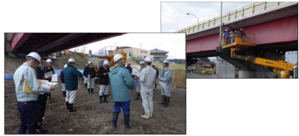
平成28年12月8日 合同現地調査状況
