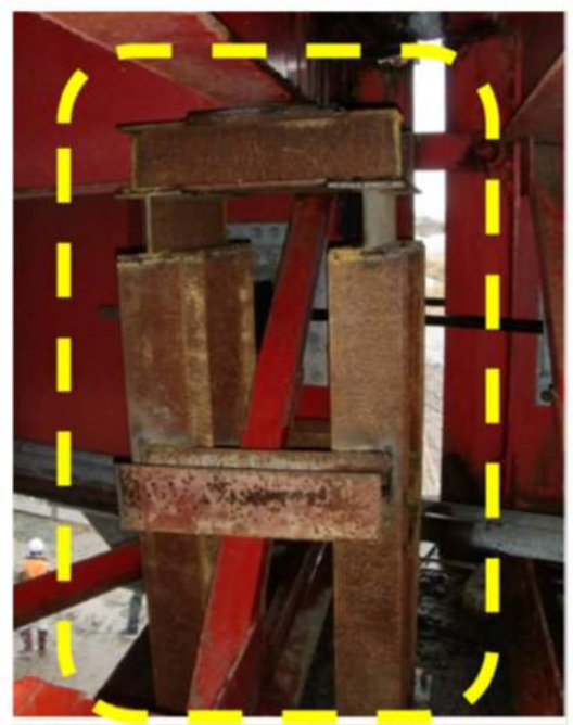
緊急対策状況(仮受け)
