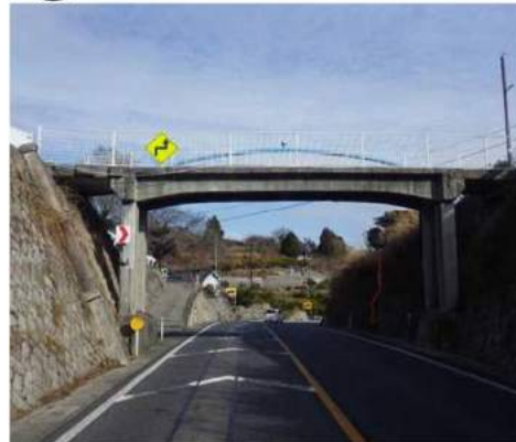
地方管理の跨道橋(未対策)
