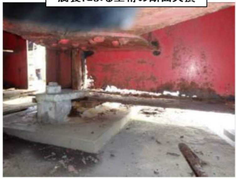
橋梁の損傷状況
