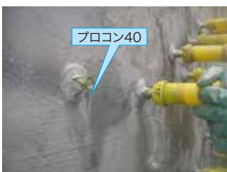
プロコン40先行注入の状況
