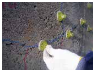
座金設置状況
