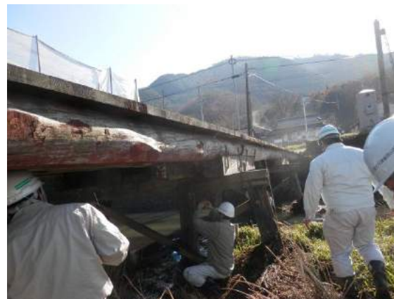
木橋（点検状況）
