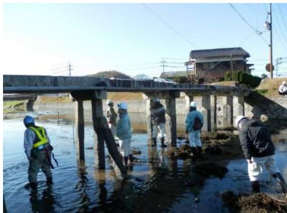
石橋（点検状況）
