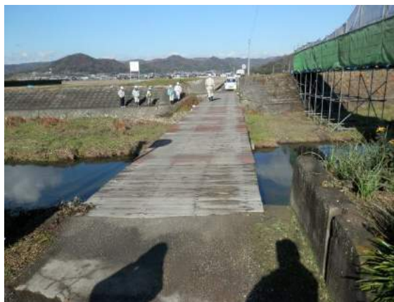
木橋（橋梁全景）
