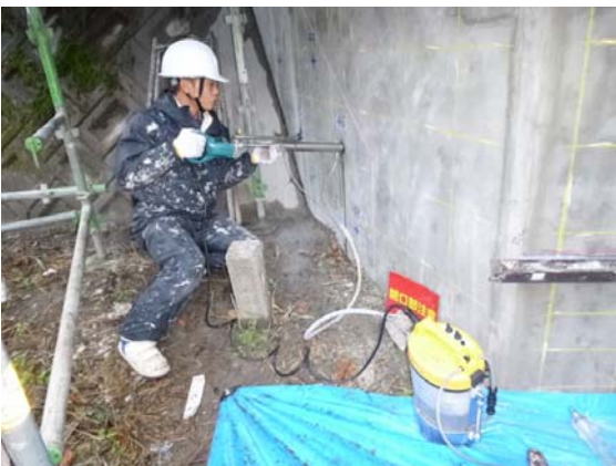
図-7 圧入孔削孔工(φ10mm)
