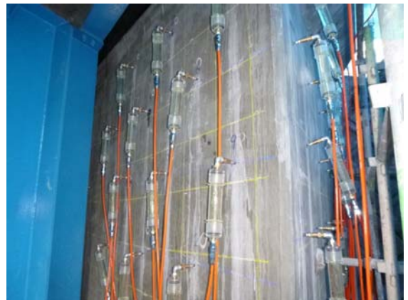
図-9 カプセル式圧入装置による内部圧入工
