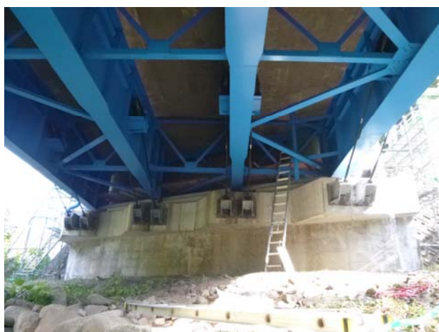
図-1 湯村大橋 A1 橋台の外観
