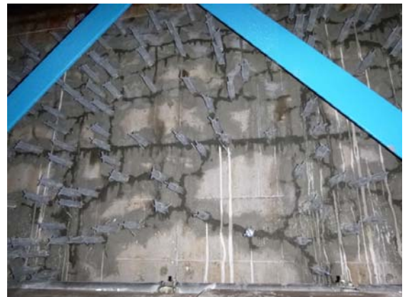
図-4 ひび割れ注入工
