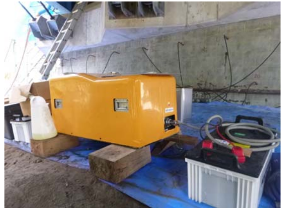
図-8 油圧式圧入装置による内部圧入工
