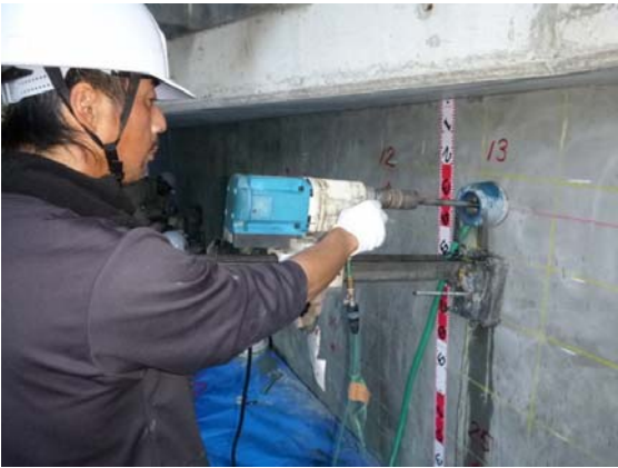
図-6 圧入孔削孔工(φ20mm)
