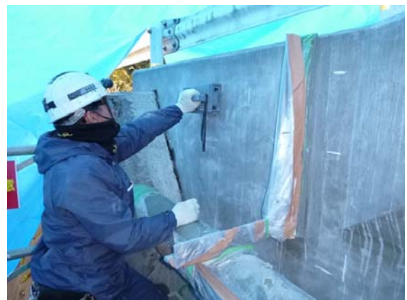
図-5 鉄筋探査工
