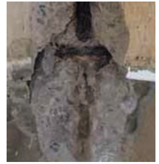
写真4 柱A境界部
