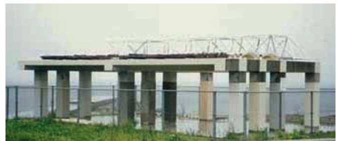
写真1 実構造物の設置状況
