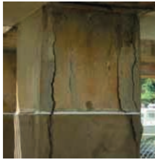
写真2 柱Aの外観
