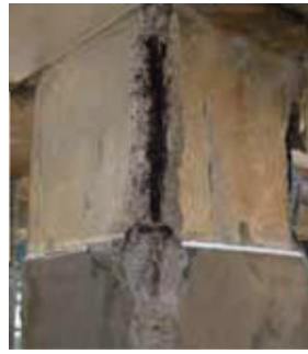
写真3 柱Aの鉄筋外観
