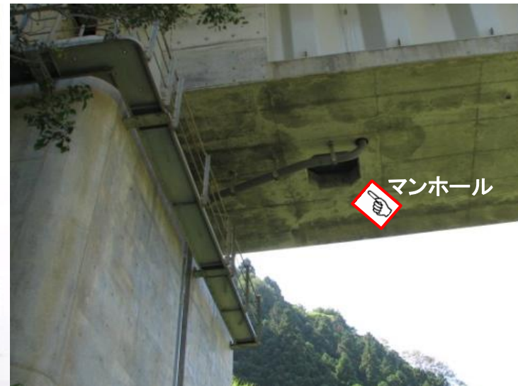
困った！ 箱桁検査口にアクセスできない...
