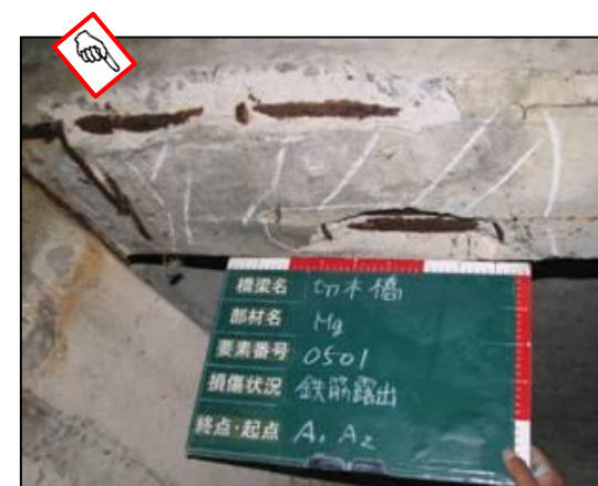
外桁端部の剥離・鉄筋露出
