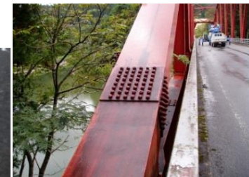
▲ボルト交換前
