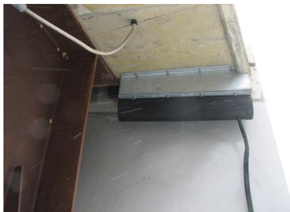
桁端部と下部工間の水処理対策
