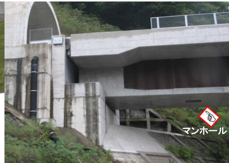
困った！ 箱桁検査口にアクセスできない...
