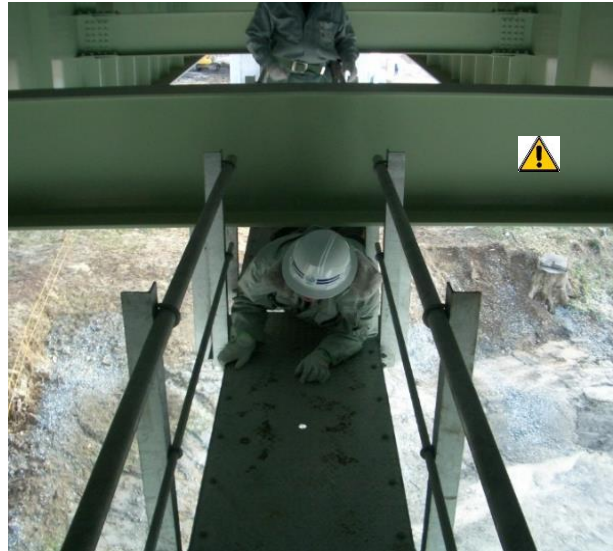
横桁が検査路を貫く！ 障害物競走じゃあるまいし...
