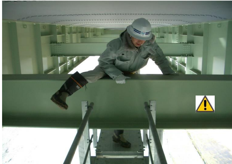
横桁が検査路を貫く！ 障害物競走じゃあるまいし...
