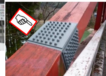
▲ボルト交換・下塗完了後
