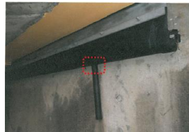
桁端部と下部工間の水処理対策
