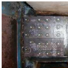
H21修繕後 (主桁修繕)
