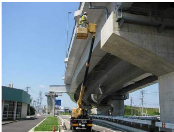
高所作業車による点検
