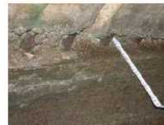
H22損傷状況 (主桁剥離)
