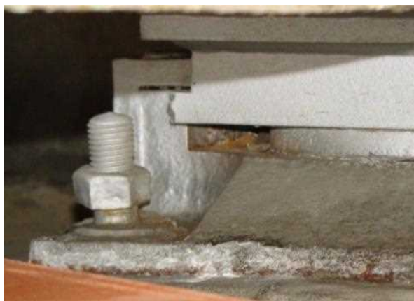
近接しなければ発見できない不具合(ボルトのゆるみ)
