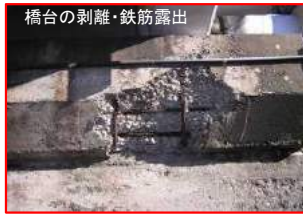
橋台の剥離・鉄筋露出
