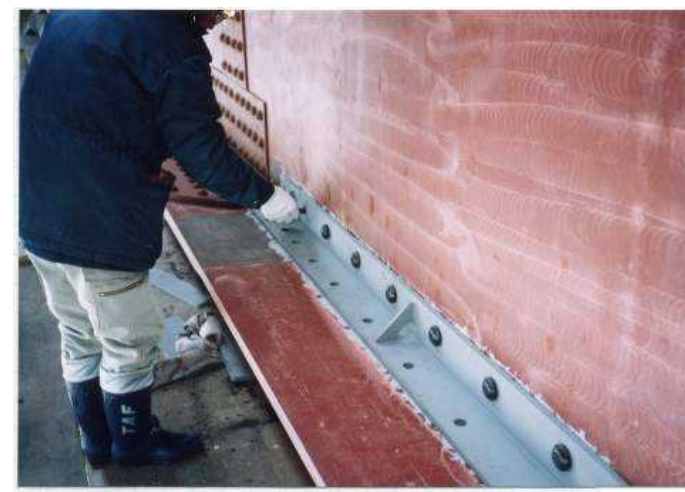
腐食部の当て板補強
