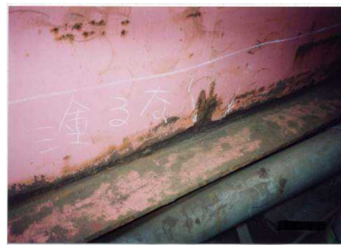
腐食部の当て板補強
