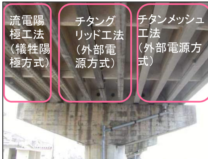
弁天大橋(平成7年施工)
