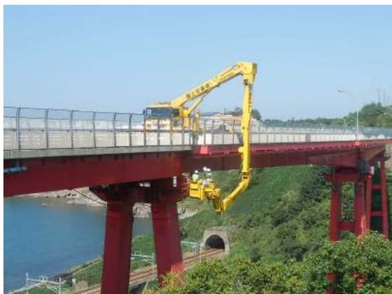
橋梁点検車による点検
