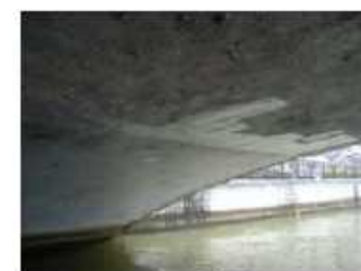
H22修繕後 (主桁修繕)
