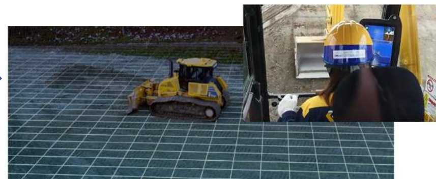
ICT建機による施工
