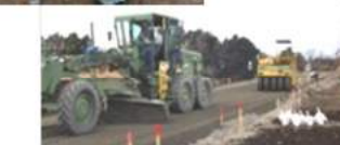
従来施工(丁張りによる施工)
