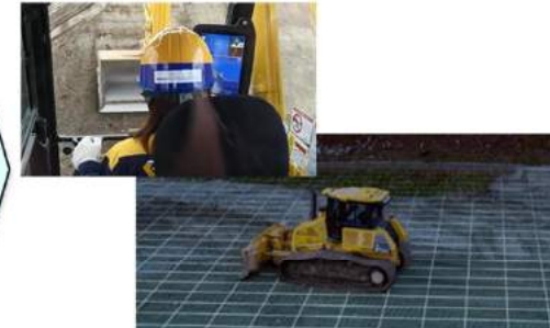
ICT建機による施工
