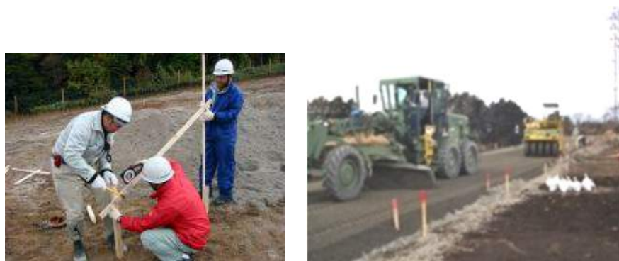
丁張りによる施工
