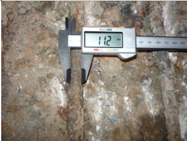
RC床版鉄筋腐食状況
