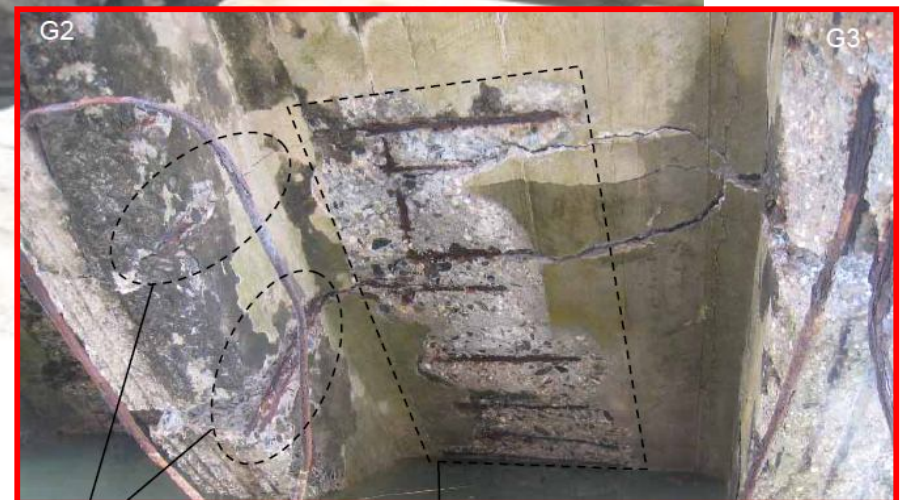
国道58号・大宜味村・旧津波橋 65歳(推定)、 平成22年4月頃崩落
