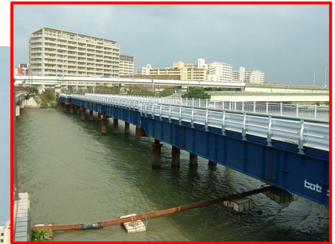
切り回しのための仮橋設置状況
