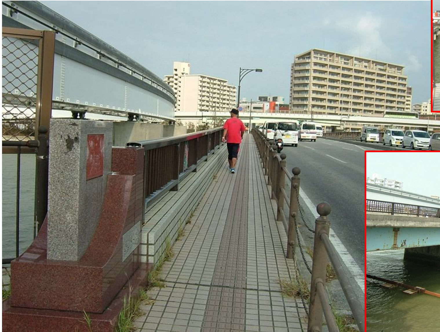
橋面写真・歩道が1m程度と狭い
