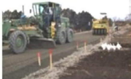
丁張りによる施工
