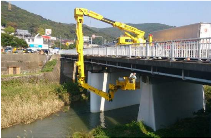
橋梁点検車による点検
