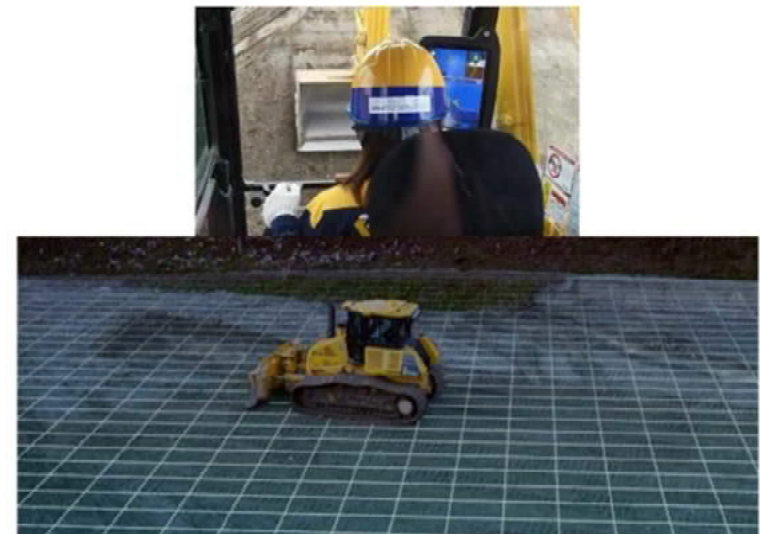
ICT建機による施工
