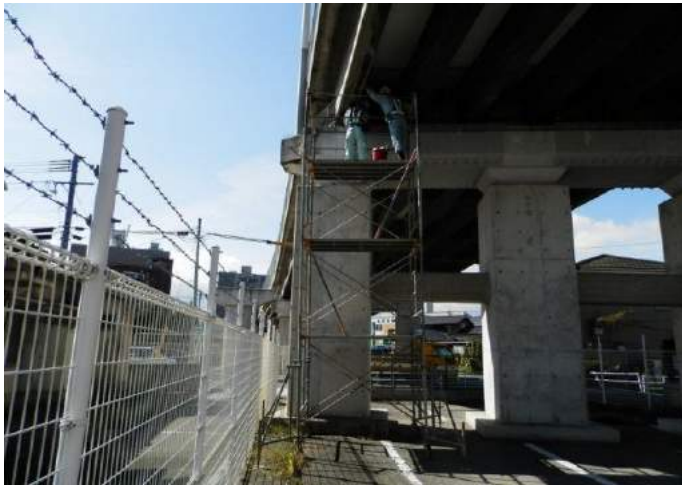
足場設置による点検
