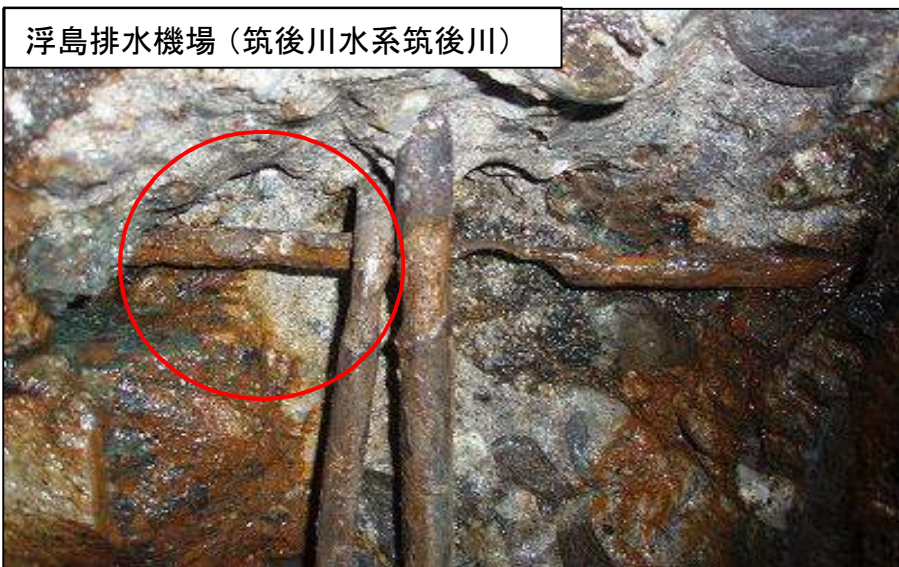
断面欠損の著しい鉄筋腐食 昭和26年設置（64年経過）
