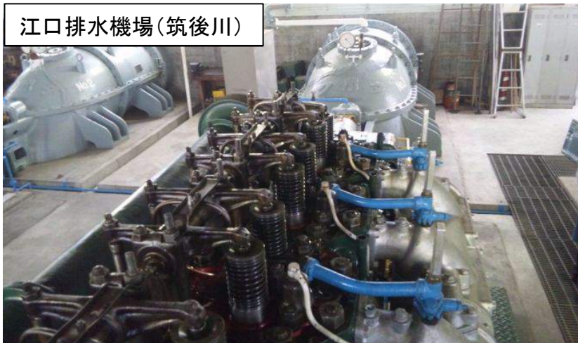
昭和33年（57年経過）に設置された、ディーゼルエンジン
