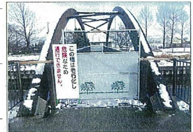
老朽化による通行止めの橋梁
