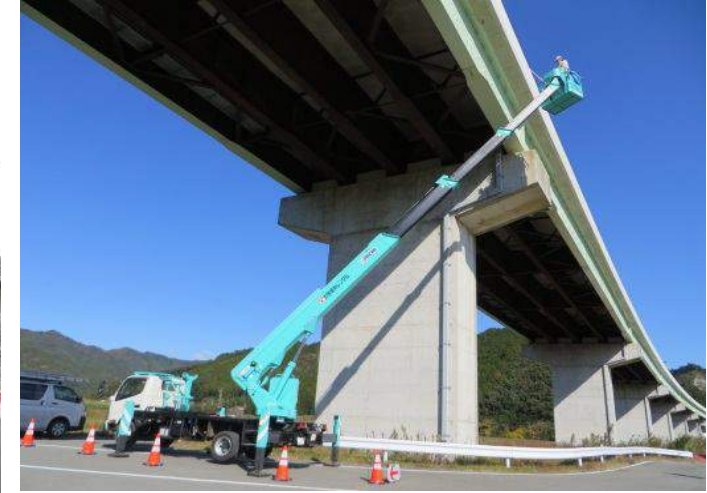
高所作業車による点検
