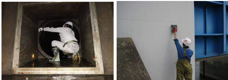
目視を主体としたコンクリート定期点検の様子
