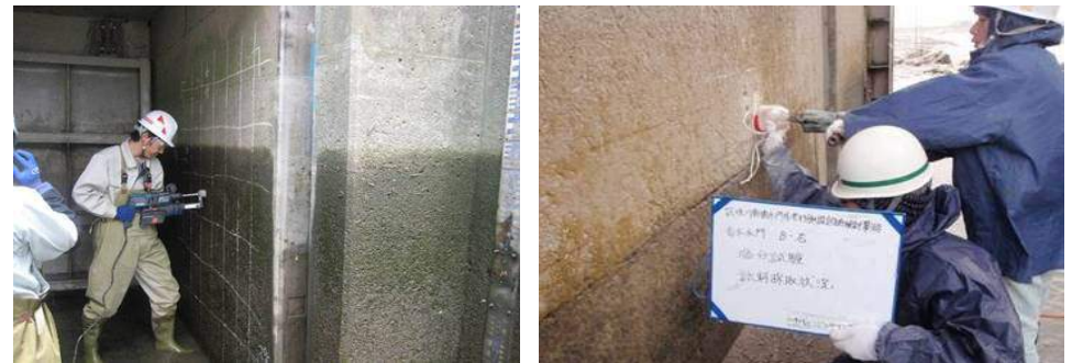
コンクリート詳細(はつり)調査の様子
