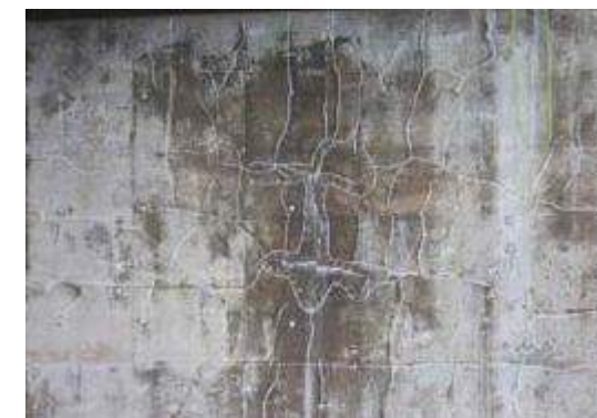
橋脚部(P1~P7)のひび割れ
