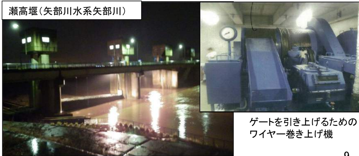
引き上げ不能となった堰のゲート 昭和61年（29年経過）
