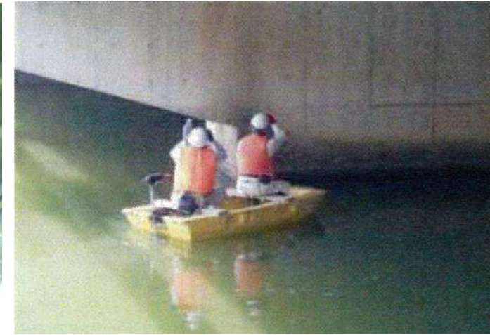
小型船舶を使用した水上での点検
