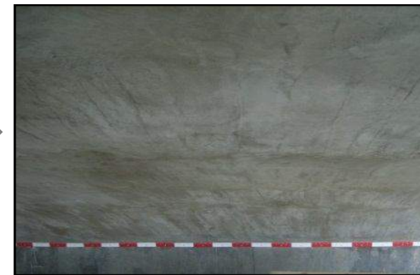
劣化部分撤去、補強、モルタル吹付け
