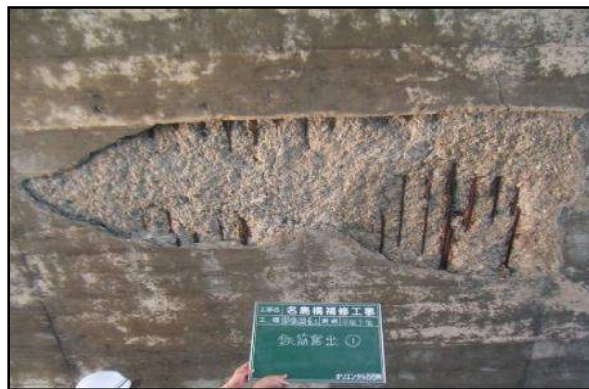
床版の剥離・鉄筋腐食
