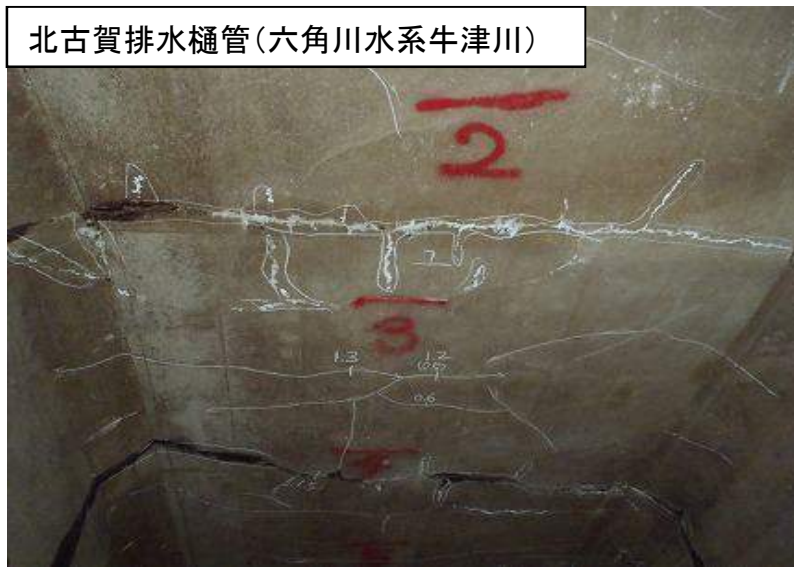
頂版に遊離石灰、漏水を伴うひび割れ 昭和56年設置（34年経過）
