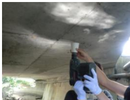
コンクリート粉末の採取状況
