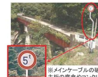
※メインケーブルの破損、主桁の腐食やコンクリート床版の剥離により通行規制を実施している事例
