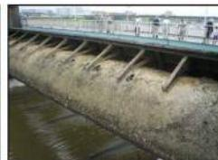
堰ゲートの腐蝕
