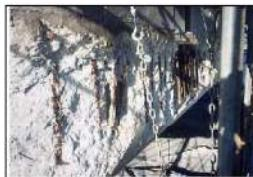
堰本体の鉄筋露出
