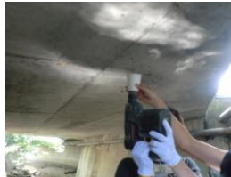
コンクリート粉末の採取状況
