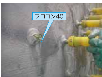
プロコン40先行注入の状況
