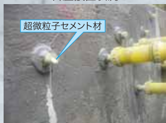
超微粒子セメント系注入材 本注入の状況
