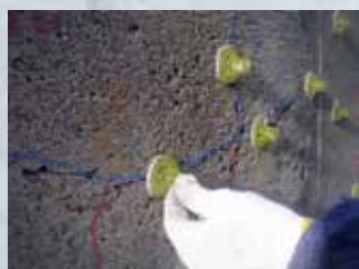
台座設置状況
