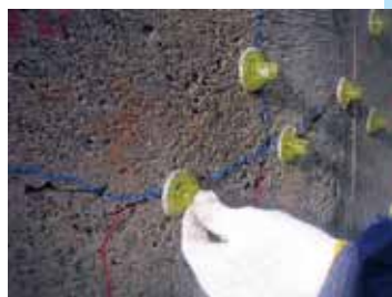
座金設置状況
