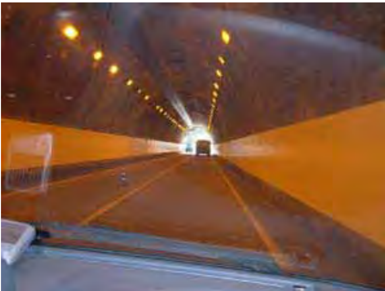
国道9号線 温泉津トンネル
