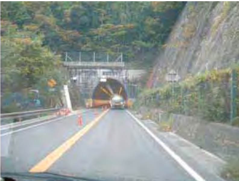
国道9号線 小浜トンネル
