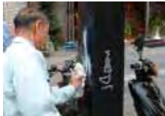
落書き除去作業
