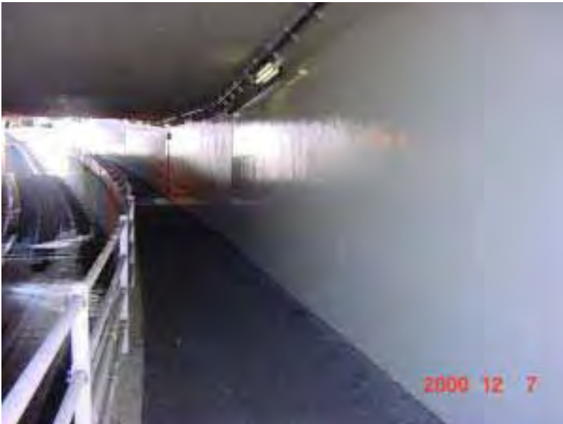
国道2号線 カルバートボックス
