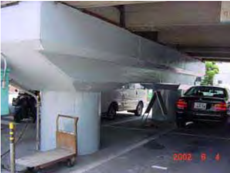
広島市 荒神陸橋
