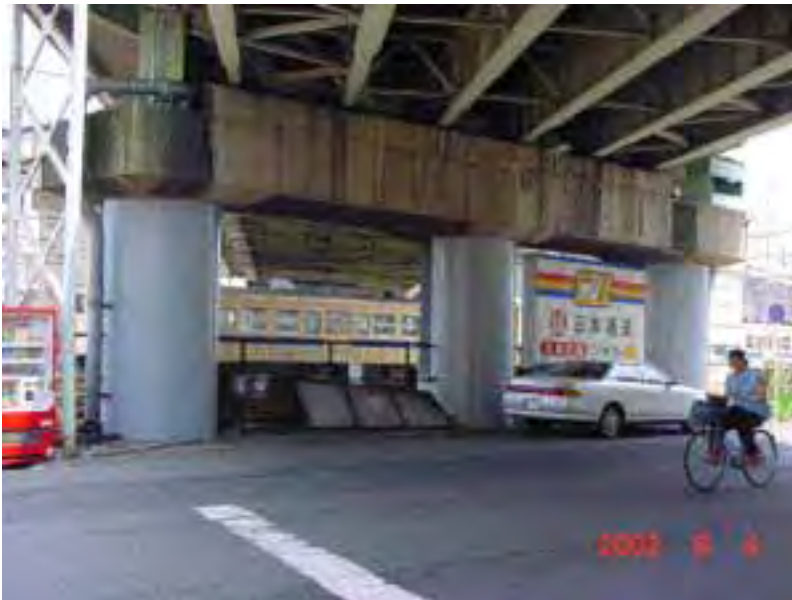
広島市 荒神陸橋
