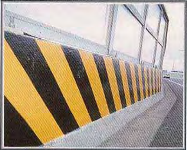
道路 融雪剤・塩害・汚れ
