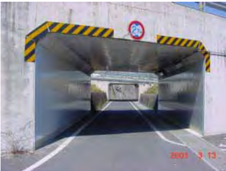
日本道路公団中国支社 カルバートボックス壁面
