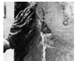
③漏水箇所をせばめる
