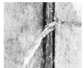
②はつりとった後、周辺をQクリートで固める
