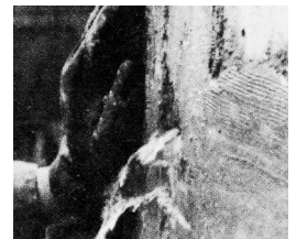
①漏水部分
