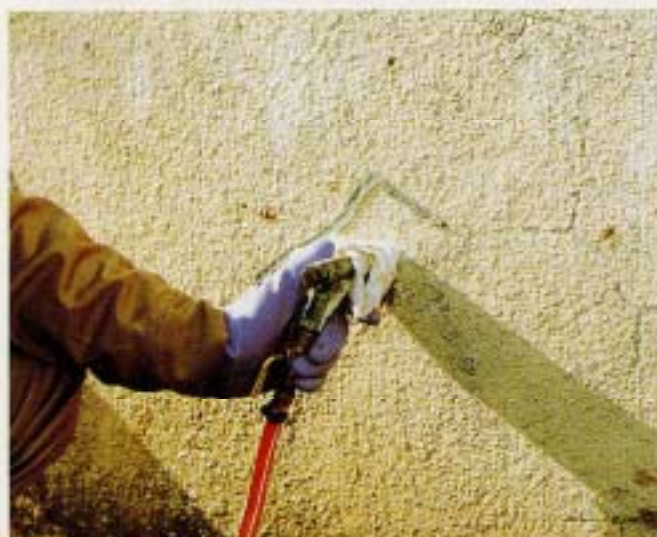
壁面でのペンギンスラリー1400の注入作業
