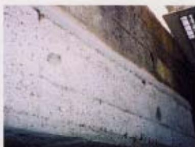
①下地処理工
