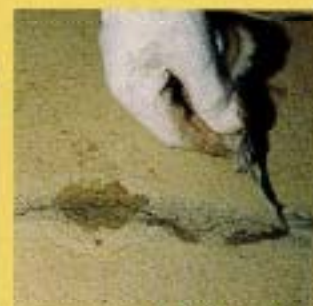
● 撤去(シール材)
