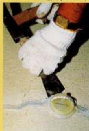
● 撤去(プレート)
