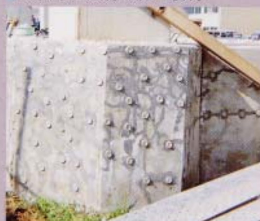
● 無機系注入材の施工状況
