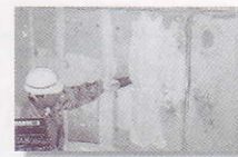
●断面修復・不陸調整
