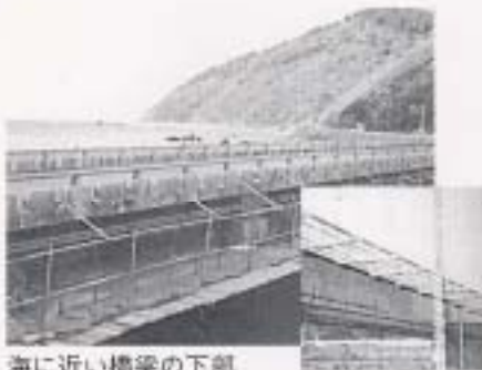
海に近い橋梁の下部
