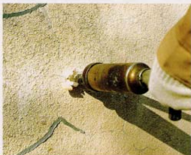
ペンギンセメント1138注入作業
