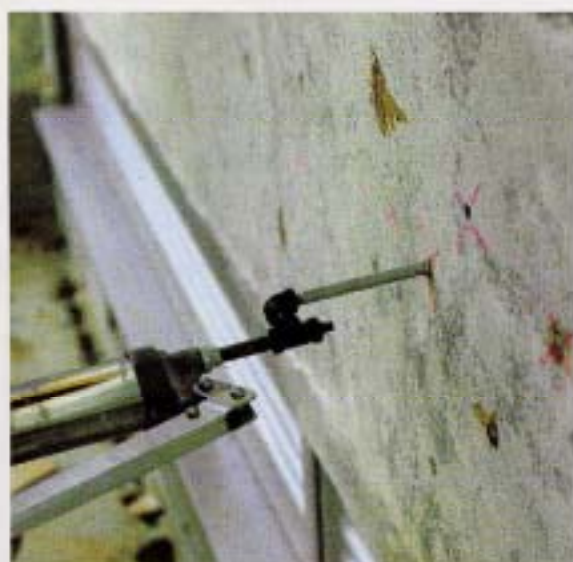
ペンギンセメント1134注入作業
