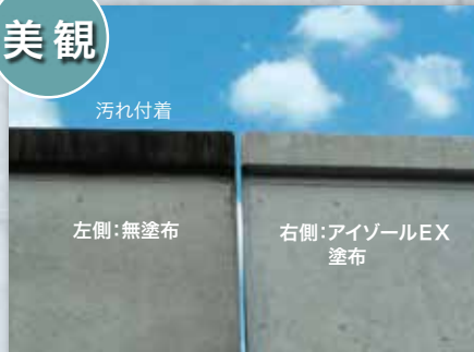
高架構橋 施工後9年
